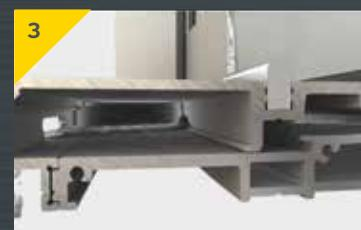
**4** Специально перфорированные профили, собранные вместе, позволяют воде отводится во внутреннюю камеру направляющей и выводится наружу.
